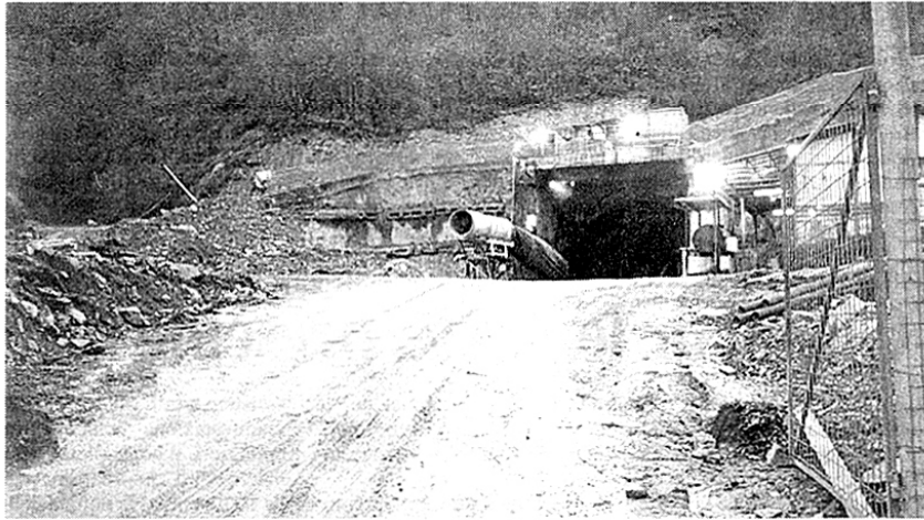
»» Il cantiere della galleria della Guinza
